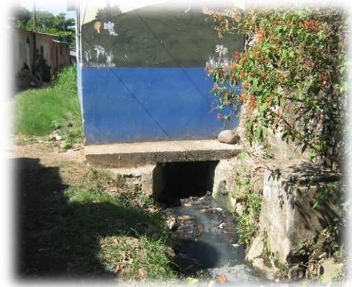
Inspección para estudio hidrológico de la calle antigua El Progreso 1, Sonsonate.
