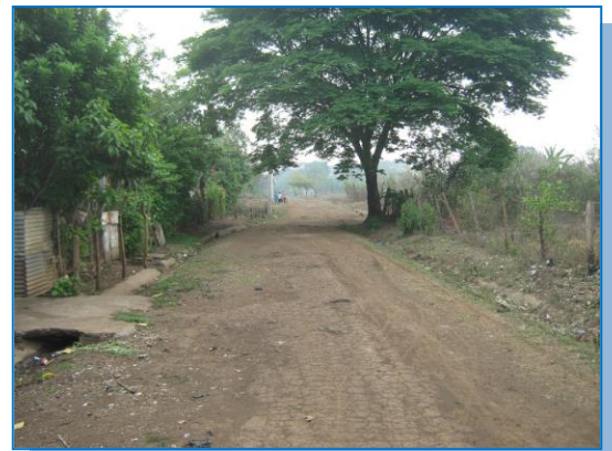
Inspección técnica para estudio hidrológico, verificación de canaletas en comunidad Paraíso Escondido.
