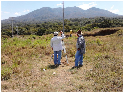
Proceso de medición de inmuebles de acuerdo con los requerimientos de planimetría y altimetría
